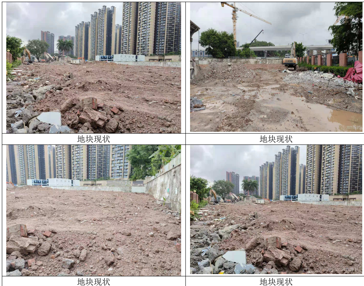
图2.1-1 2021年5月现场踏勘地块情况照片
