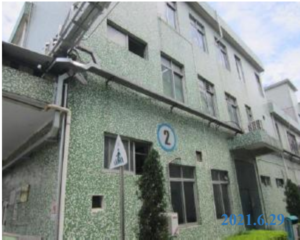
项目 15 座北面厂房
