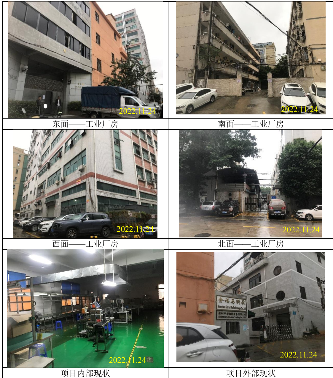
附图 4 项目厂房外观和车间内现状
